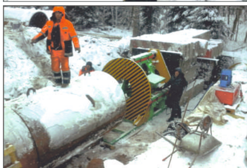
Установка УГ600Т в работе
