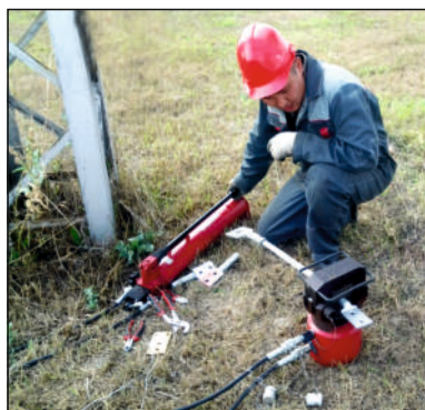
На фото ПН100 в работе
