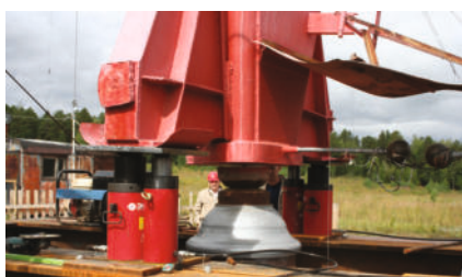
Подъем вышки связи и ее удержание на время замены изолятора
