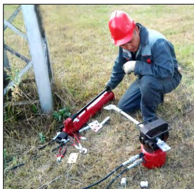
На фото ПН100 в работе
